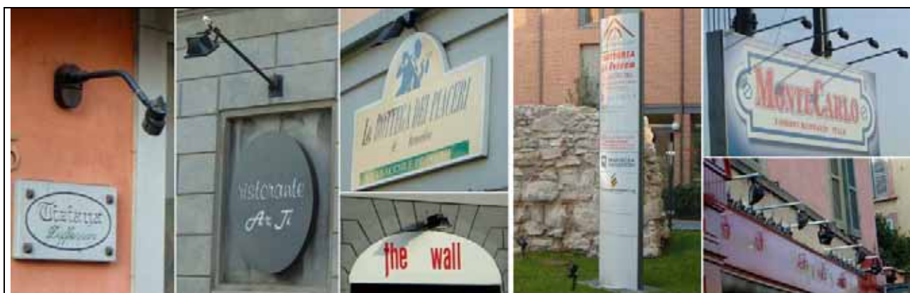
Fig.17 – Esempi di insegne prive di illuminazione propria. Le tre insegne di sinistra sono conformi alla L.r.17/09 in illuminante dall'alto verso il basso con apparecchi orizzontali o inclinati ma con flusso intercettato dalla parete. A destra 2 insegne non conformi alla L.r. 17/09 in quanto la prima è illuminata dal basso e il pannello pubblicitario è illuminato dall'alto ma con corpi illuminanti inclinati con flusso non intercettato dalla sagoma.
